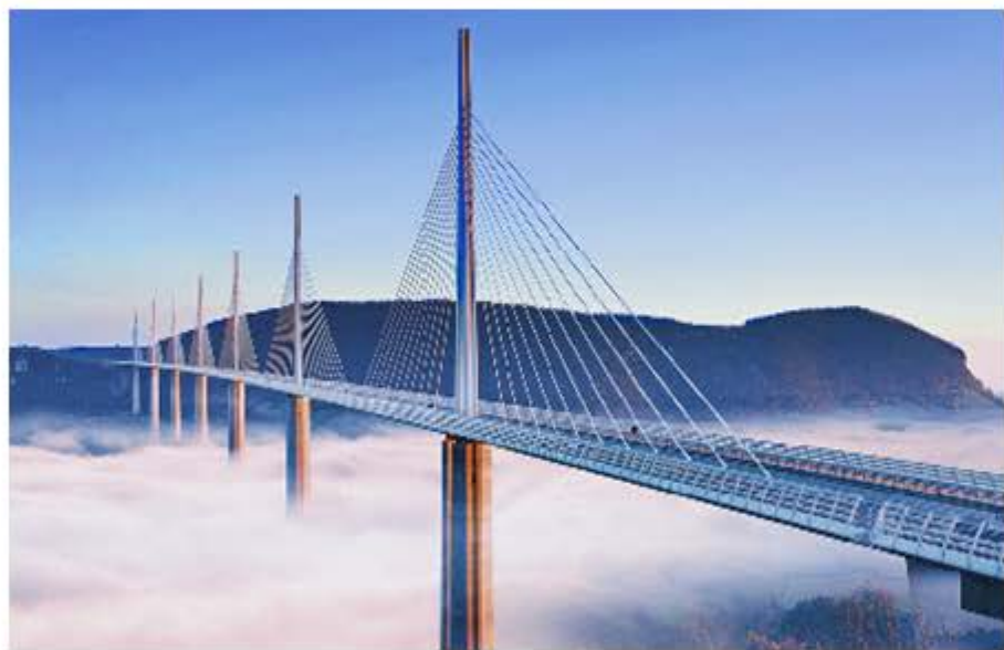
桥板下凹的处理
